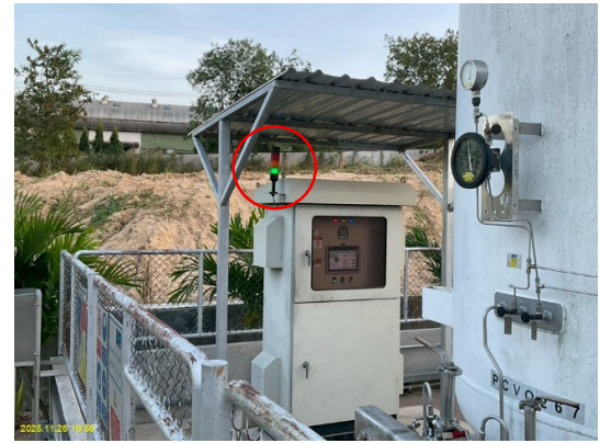
ติดตั้งระบบสัญญาณไฟเพื่อตรวจจับและแจ้งเตือนสถานะที่ปลอดภัยของการผสมก๊าซคาร์บอนไดออกไซด์
