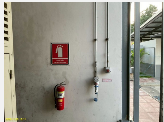
ติดตั้งสวิตช์หยุดการทำงานเมื่อมีเหตุฉุกเฉินไว้บริเวณอาคารเครื่องสูบน้ำอัดก๊าซธรรมชาติ
